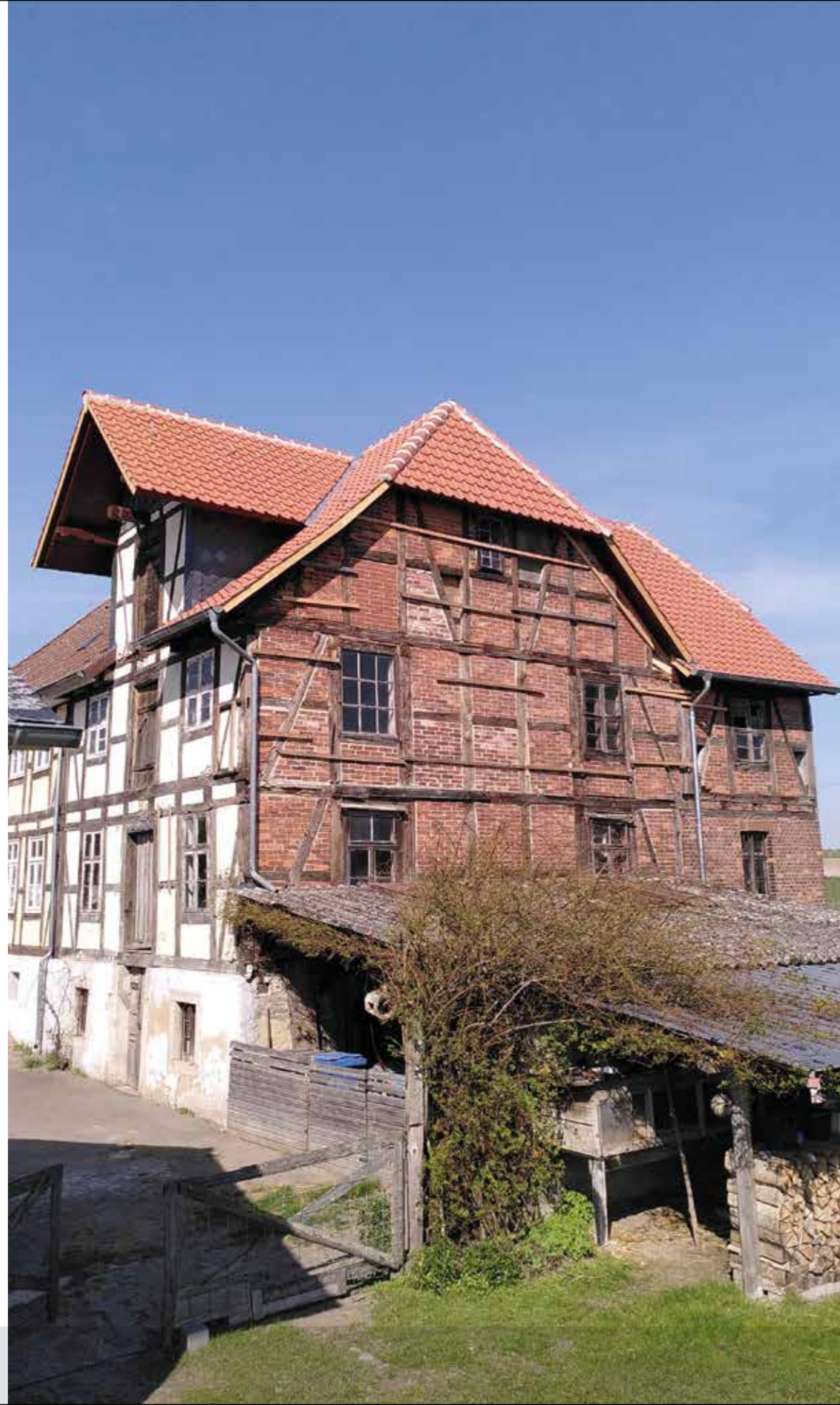
Mühle Jensen mit neuem Dach.
