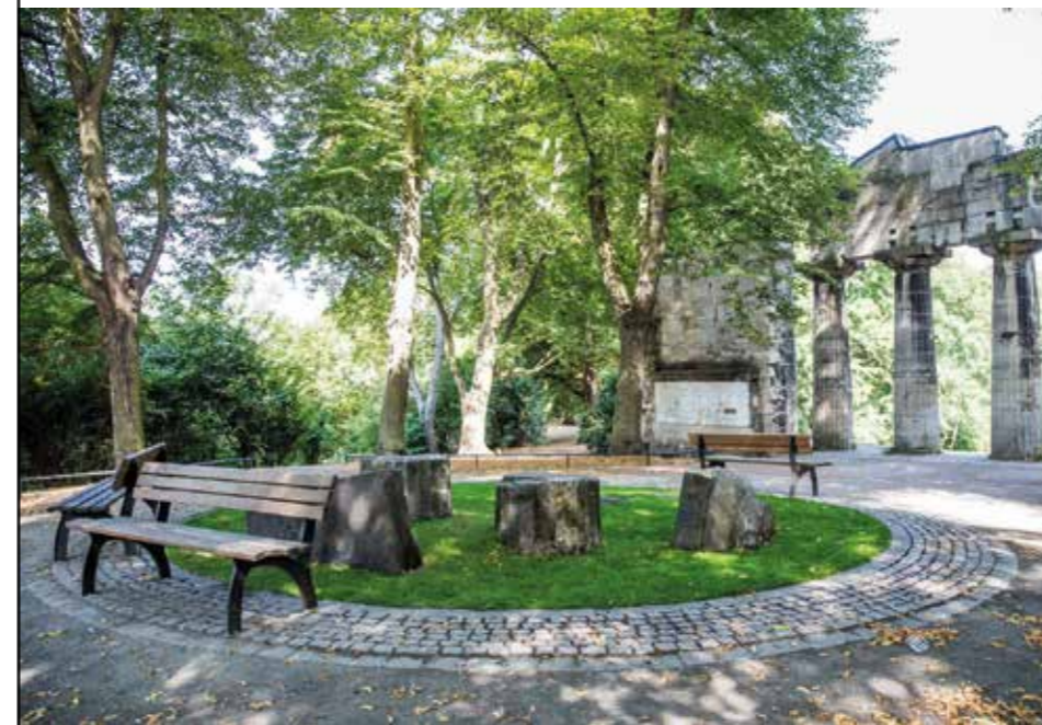
Saniertes Rondell vor dem Portikus im Bürgerpark.
